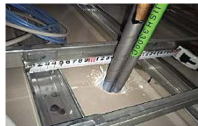
配線工事による貫通
